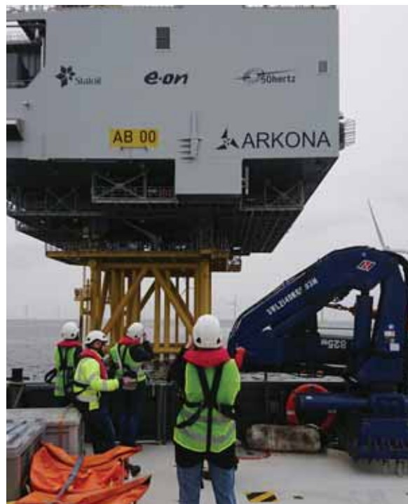
Das Projektteam beim Vor-Ort-Termin im E.ON Windpark Arkona, Insel Rügen. (Foto: Projekt MARLA)
