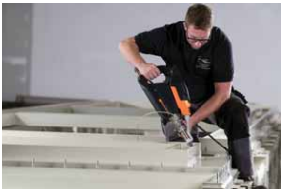
Der Munsch Max im Arbeitseinsatz beim Verschweißen von Kunststoffplatten.
