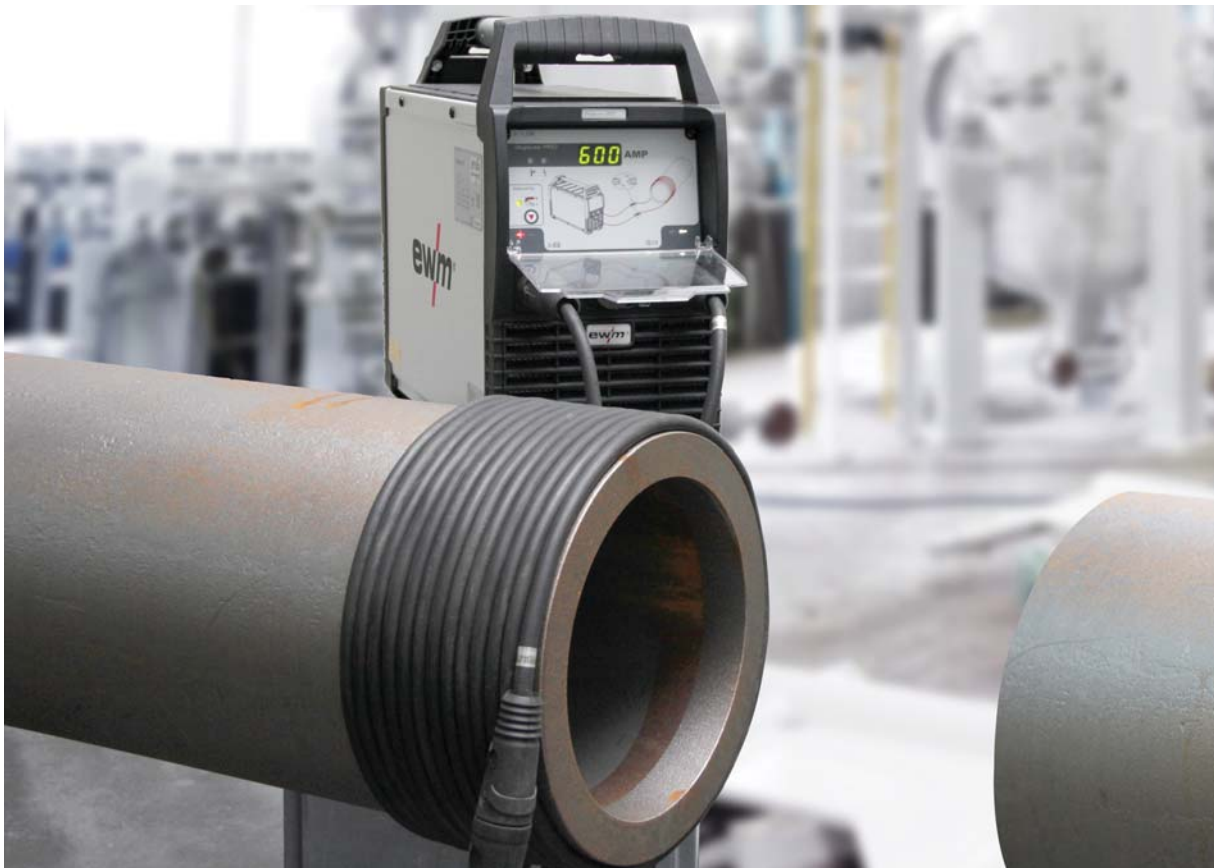
Feldstärkemessung unmittelbar vor dem Schweißen. Das neue Rohrstück wurde nicht entmagnetisiert. (Foto: ewm)
